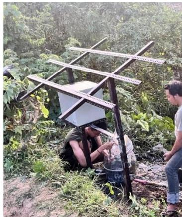
Gambar 3. Perakitan rangka panel surya
