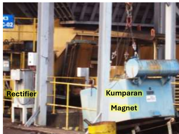
Gambar 2. Rectifier dan Kumpanan Magnet
