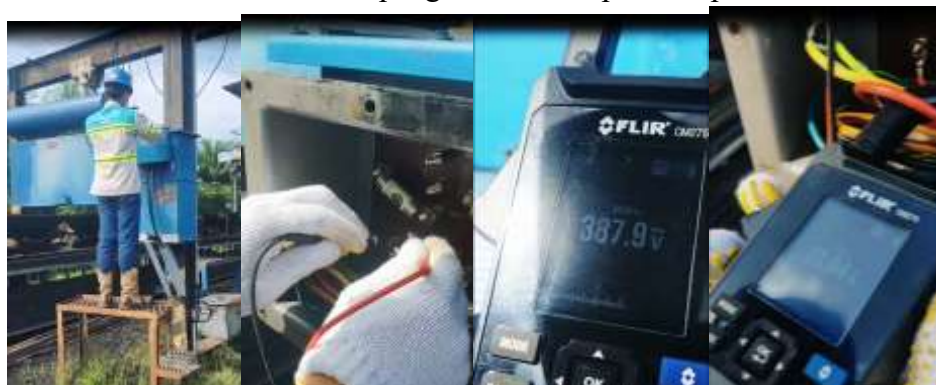
Gambar 3. Pengecekan/Inspeksi Magnet Separator
